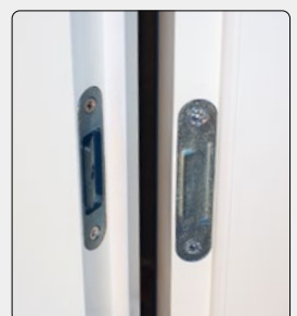
Bandseitensicherung
