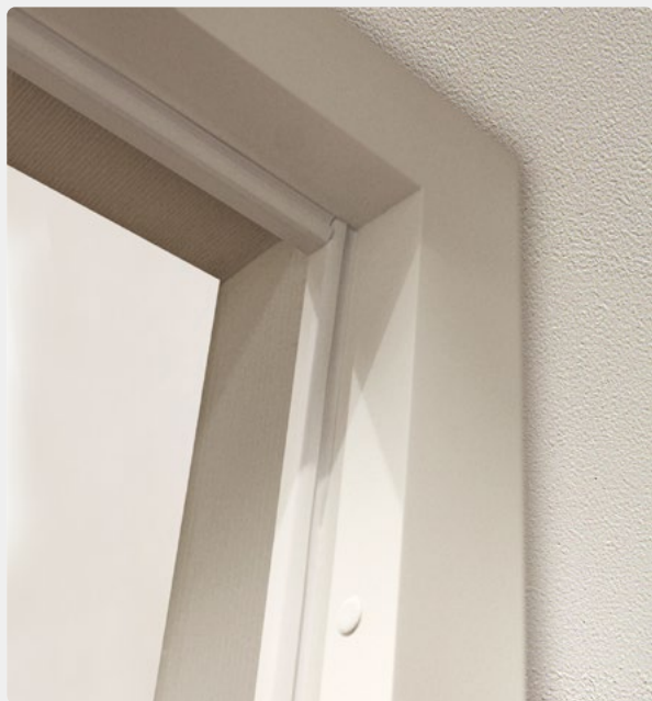
Blendrahmen auf der Wand
